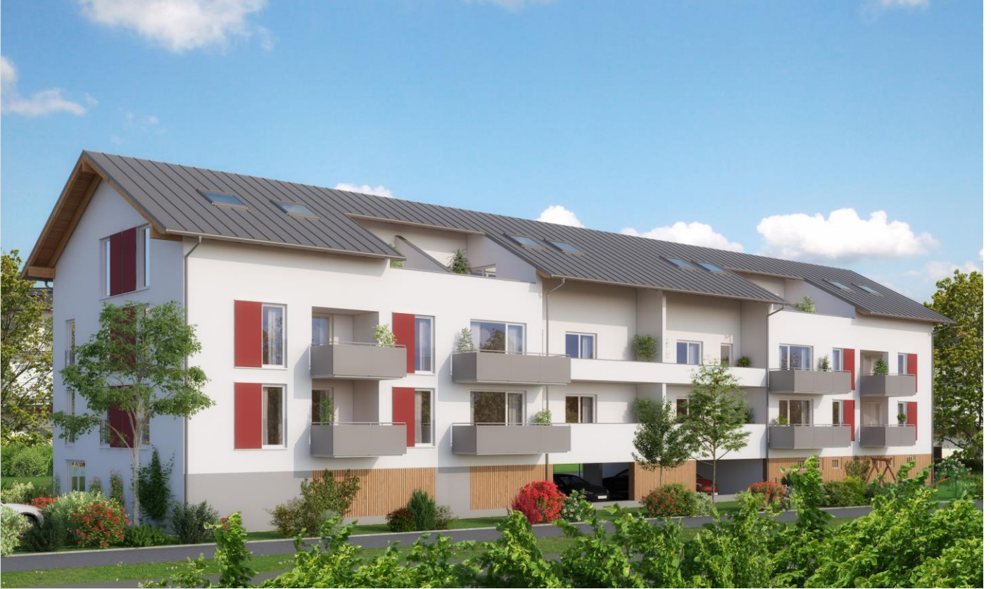
Westerham-Lodges Ansicht außen
